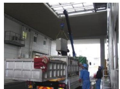
PCB廃棄物搬出作業
