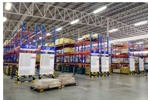
LED照明を採用した新倉庫棟 (ジャノメタイランド㈱)
