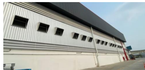
新たに設置した換気用ダクト (ジャノメタイランド㈱)
