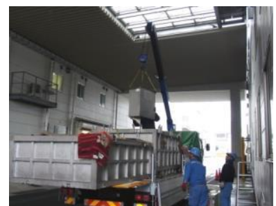
PCB廃棄物搬出作業
