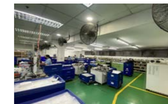
エアコンに替えて空冷式チラーを導入(ジャノメタイランド(株))
