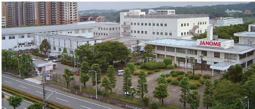
八王子地区事業所全景（中央は今年4月に完成した3号棟）
