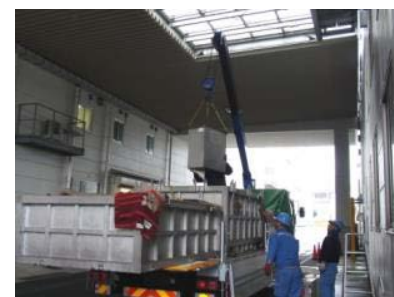
PCB廃棄物搬出作業
